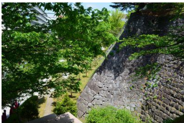
二の丸の高石垣と隅角部を支える算木積み
