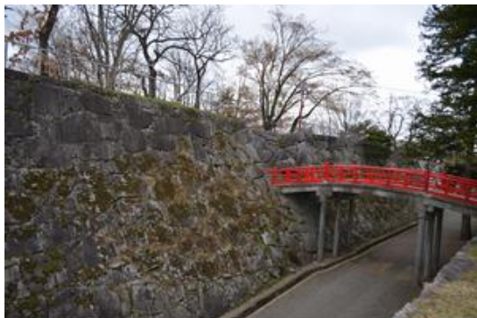
本丸と二の丸を結ぶ廊下橋
