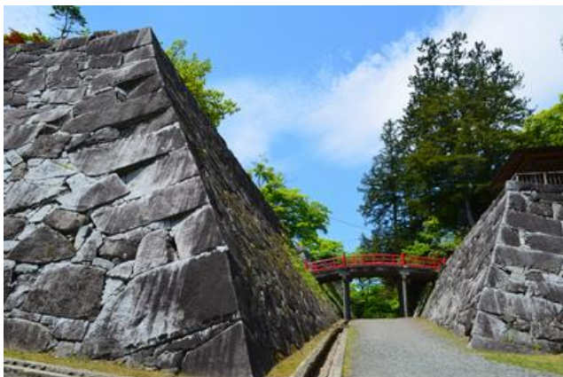
左右の石垣は平成の大修理による積み直しだが忠実に復元されている
